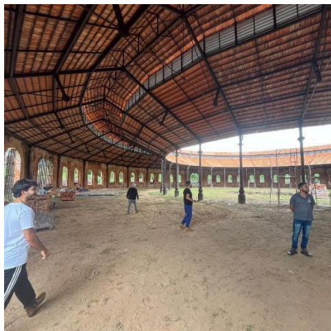
Vista interna da cobertura da Rotunda. Autoria: Eduardo Santos Data: 06/02/2026
