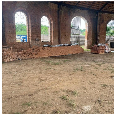
Alvenaria e esquadrias da Rotunda. Autoria: Eduardo Santos Data: 06/02/2026
